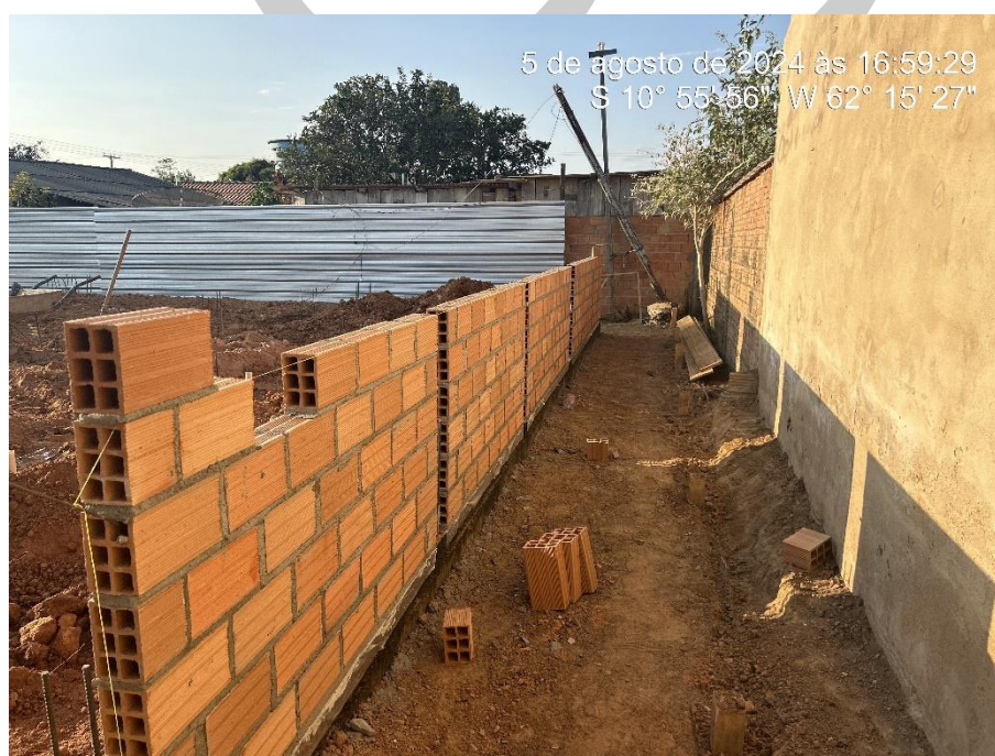
Figura 10: Início da alvenaria;
