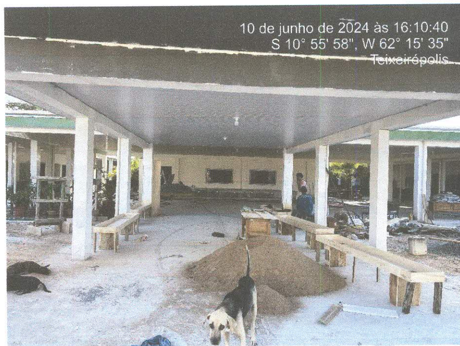
Figura 1: Passarela sendo finalizada;
