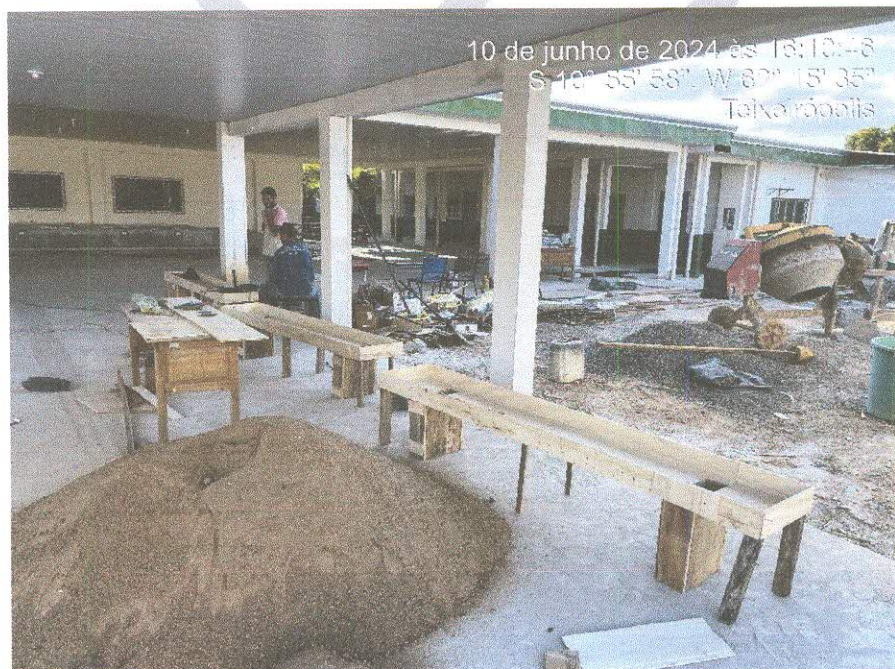
Figura 2: Bancos de concreto sendo finalizados;
