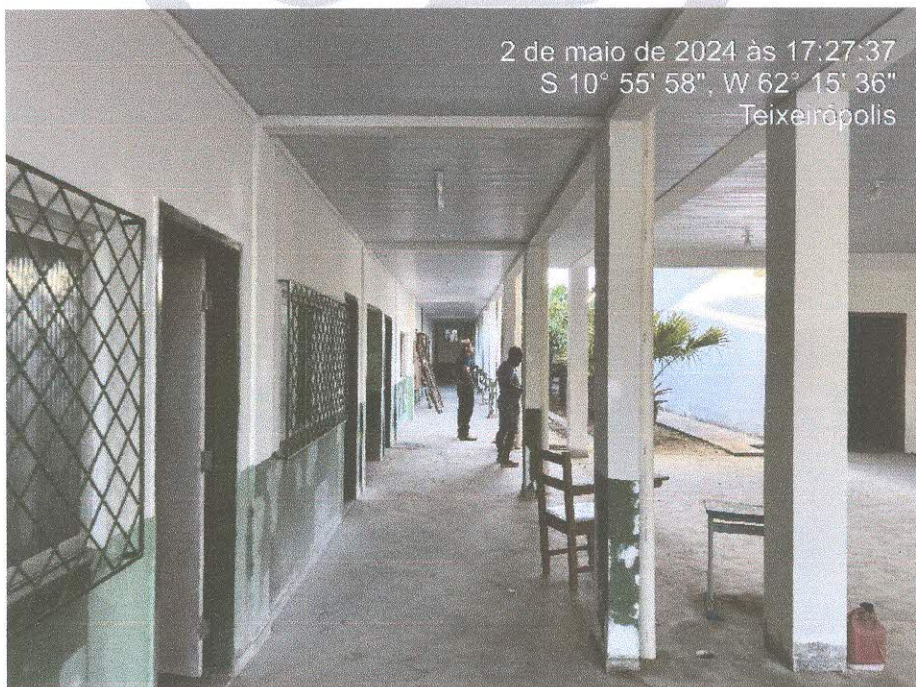
Figura 6: Instalações elétricas sendo finalizadas;
