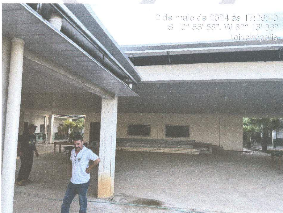
Figura 2: Drenagem pluvial finalizada;
