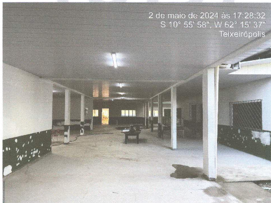
Figura 3: Forro PVC finalizado;
