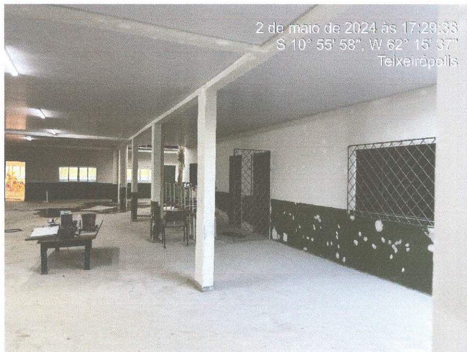
Figura 3: Forro PVC finalizado;
