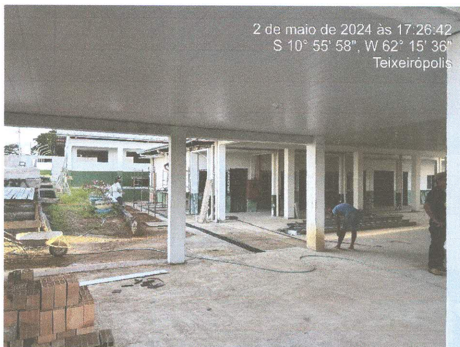
Figura 1: Forro PVC finalizado;
