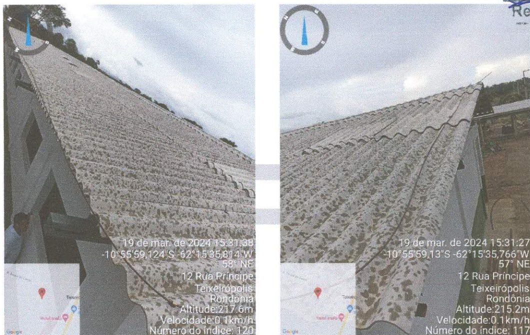
Figura 5: Instalação de Cordoalha de 35mm para SPDA;
