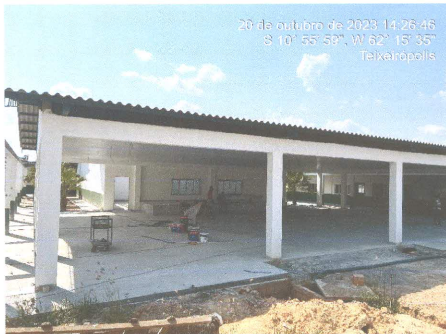
Figura 1: Piso granilite, instalação elétrica e forro do pátio finalizado;
