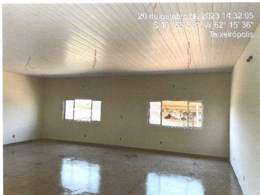
Figura 11: Polimento do piso granilite, instalação elétrica, pintura e forro finalizado
