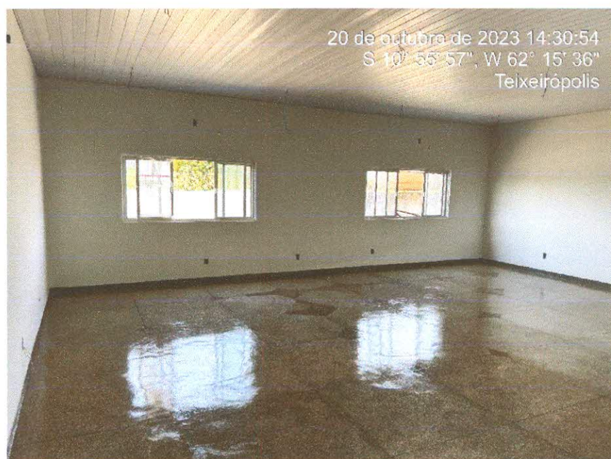
Figura 10: Polimento do piso granilite, instalação elétrica, pintura e forro finalizado;
