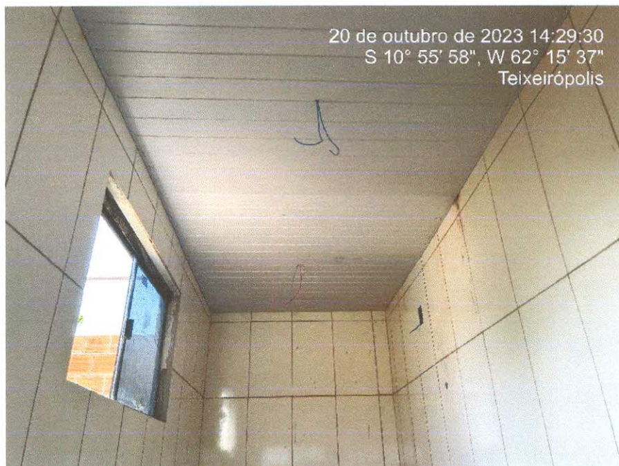
Figura 7: Forro banheiros finalizados;
