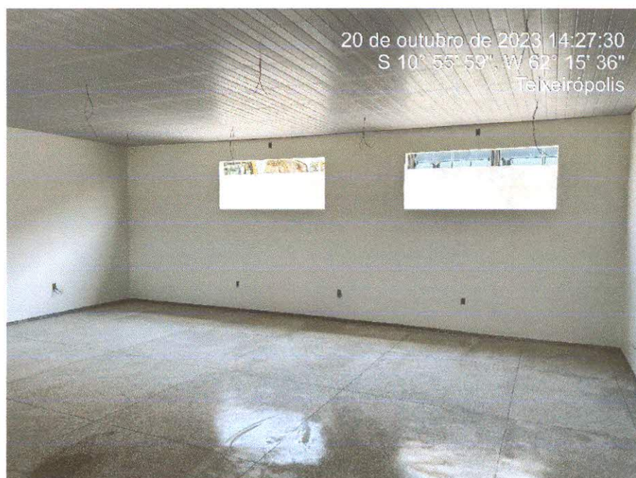
Figura 6: Polimento do piso granilite, instalação elétrica e forro finalizado;
