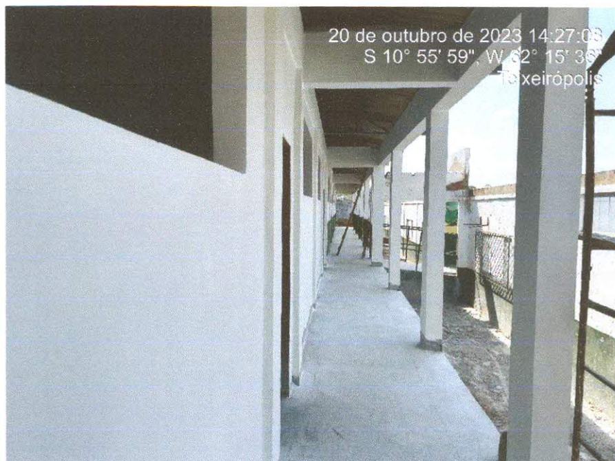
Figura 4: Pintura em andamento;
