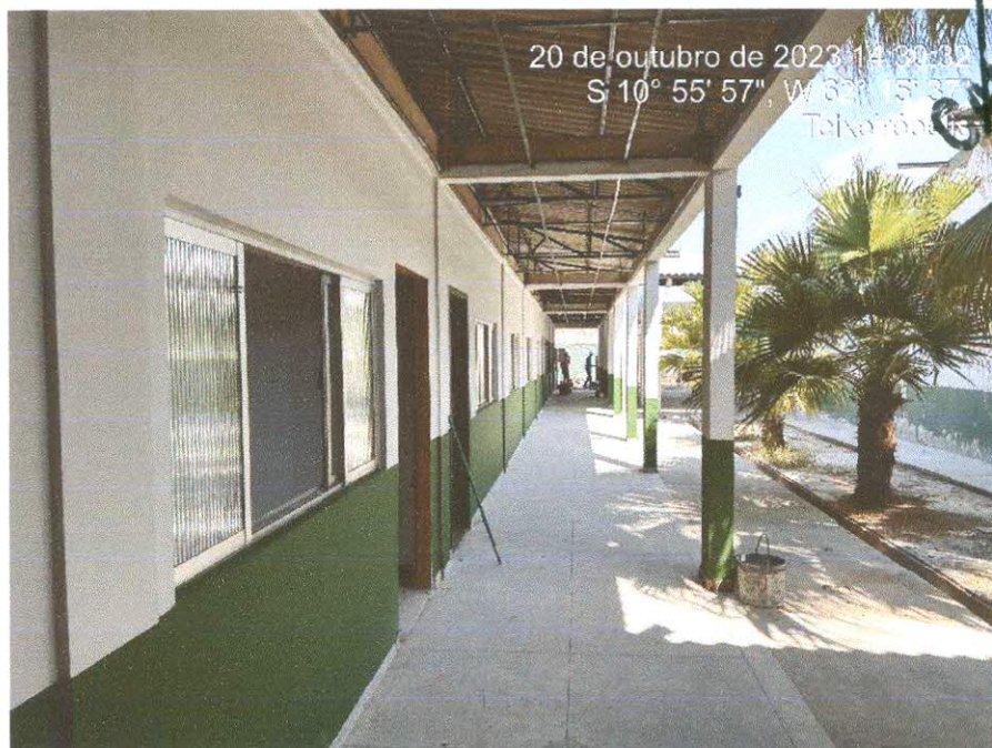
Figura 9: Pintura em andamento;
