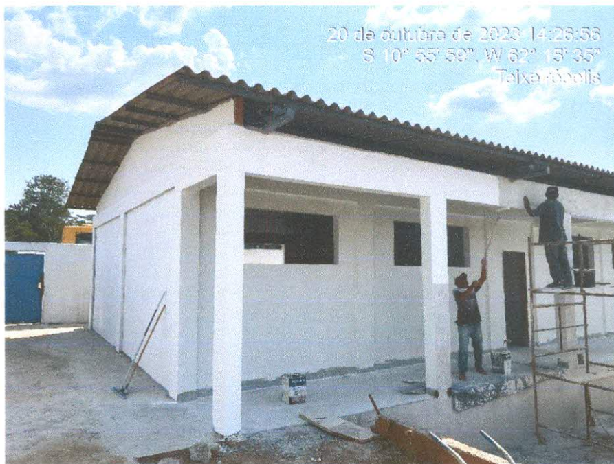
Figura 3: Pintura em andamento;
