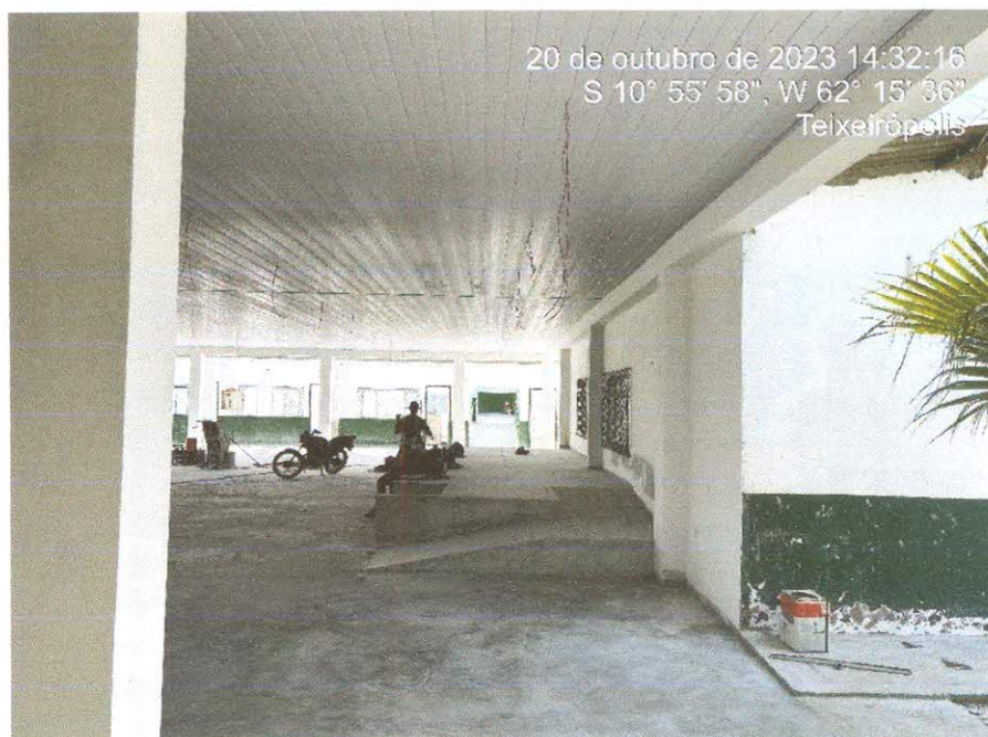
Figura 12: Piso granilite, instalação elétrica e forro do pátio finalizado;
