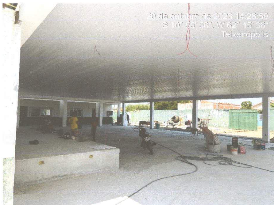
Figura 2: Piso granilite, instalação elétrica e forro do pátio finalizado;
