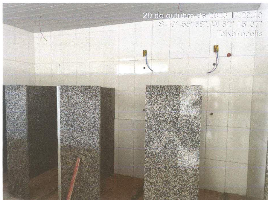
Figura 8: Forro banheiros finalizados;
