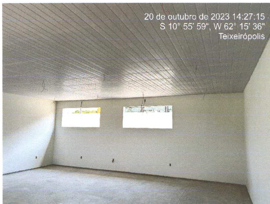
Figura 5: Polimento do piso granilite, instalação elétrica e forro finalizado;
