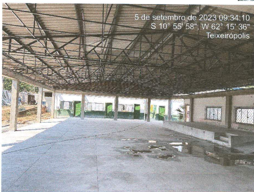
Figura 1: Piso granilite e instalação elétrica em andamento;
