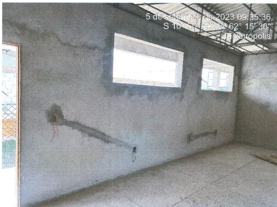
Figura 6: Piso granilite e instalação elétrica em andamento;
