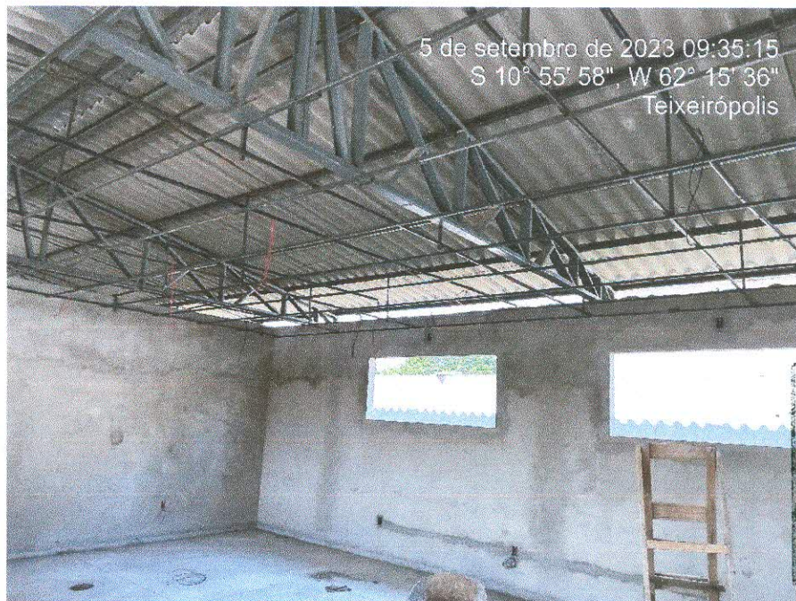
Figura 5: Piso granilite e instalação elétrica em andamento;
