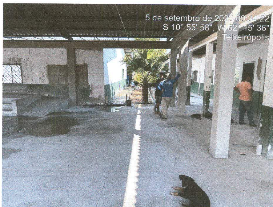
Figura 2: Piso granilite e instalação elétrica em andamento;
