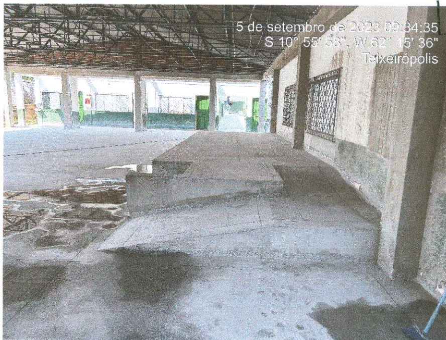
Figura 3: Piso granilite e instalação elétrica em andamento;
