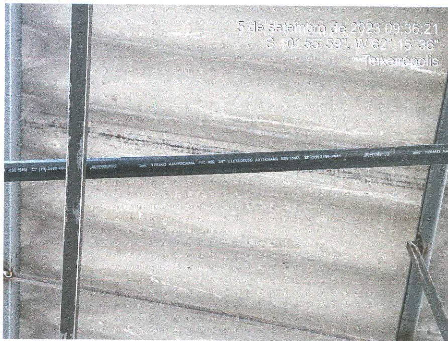
Figura 9: Instalação elétrica em andamento;
