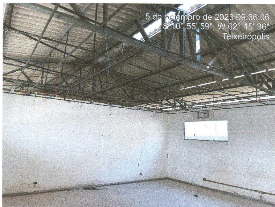
Figura 8: Piso granilite e instalação elétrica em andamento;
