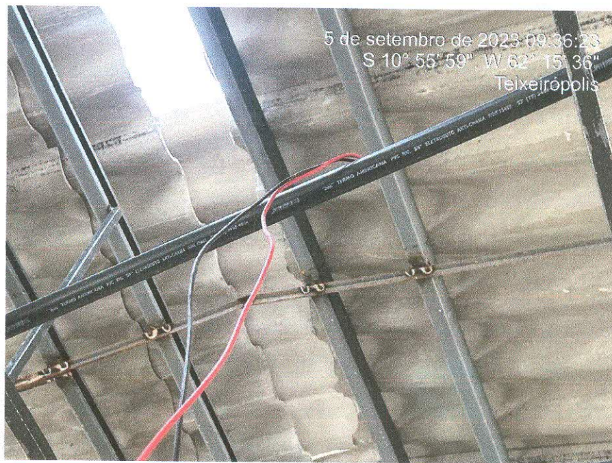
Figura 10: Instalação elétrica em andamento;
