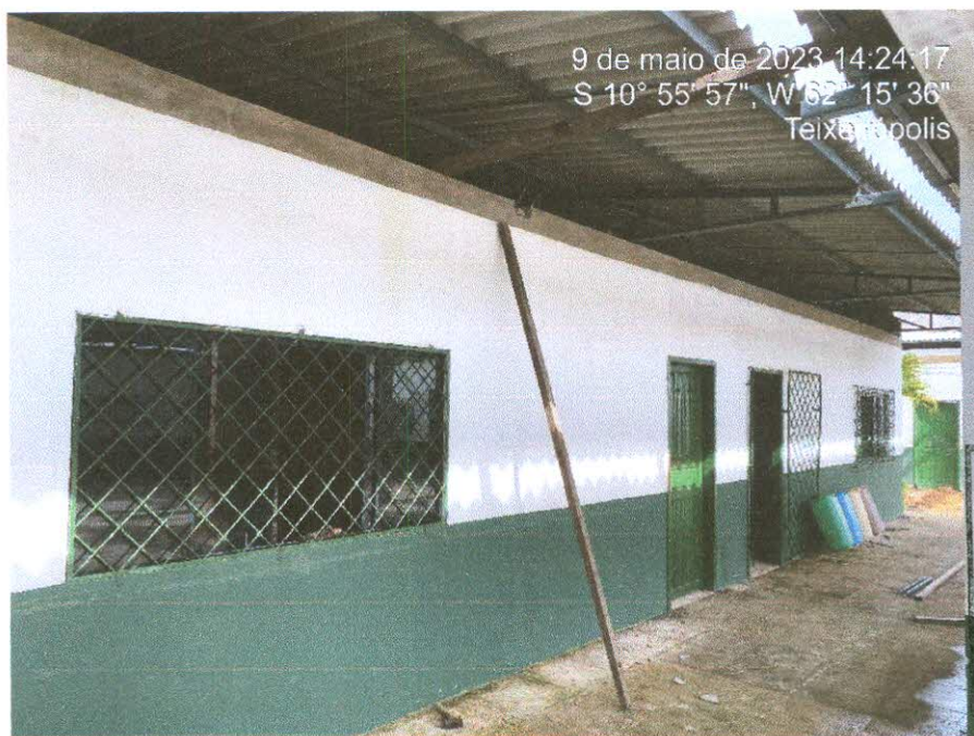
Figura 9: Telhamento com telha fibrocimento 6mm;
