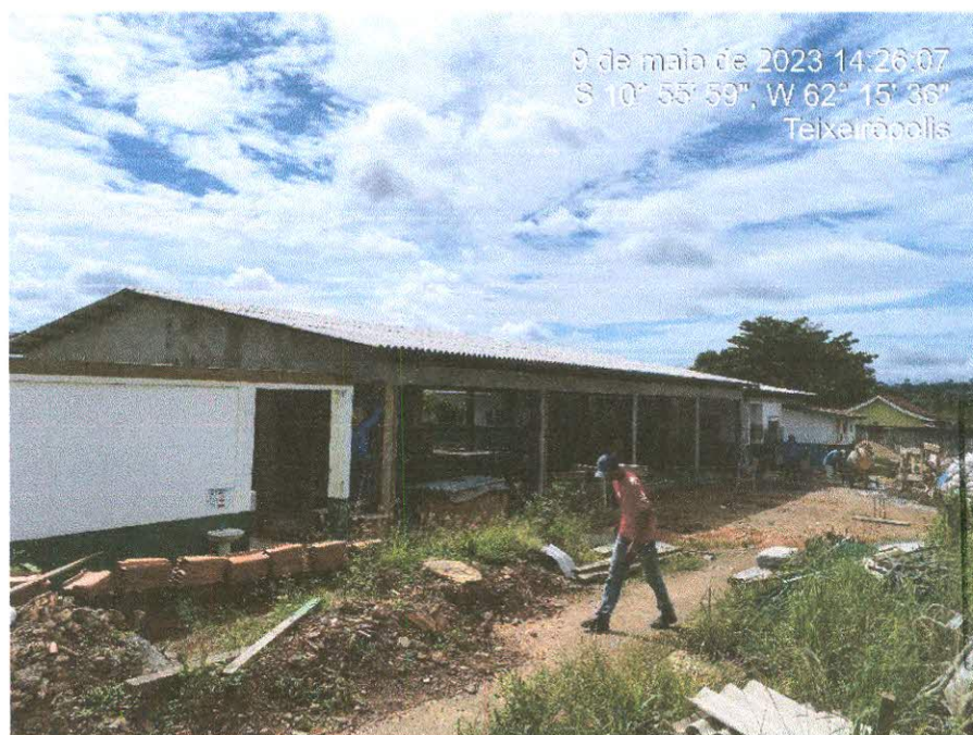
Figura 7: Telhamento com telha fibrocimento 6mm;;
