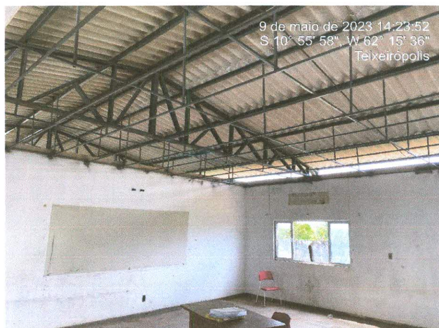
Figura 8: Tarugamento do forro iniciado;
