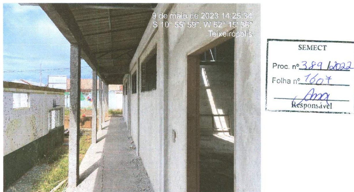
Figura 3: Telhamento com telha fibrocimento 6mm;
