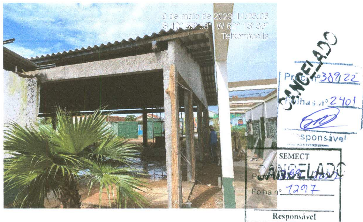
Figura 3: Telhamento com telha fibrocimento 6mm;
