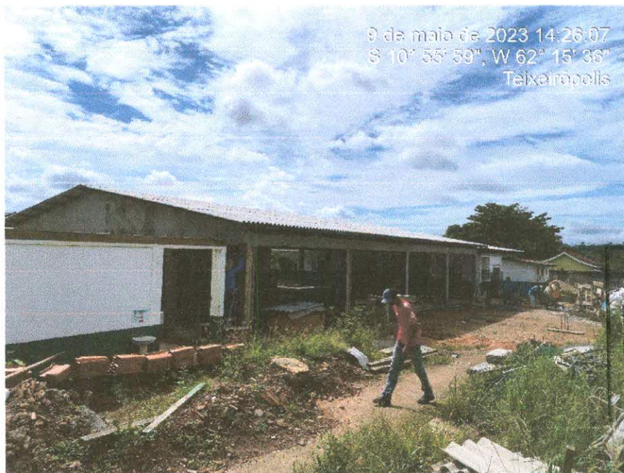
Figura 7: Telhamento com telha fibrocimento 6mm;;
