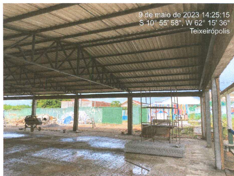
Figura 2: Estrutura metálica do pátio e telhamento com telha fibrocimento 6mm;
