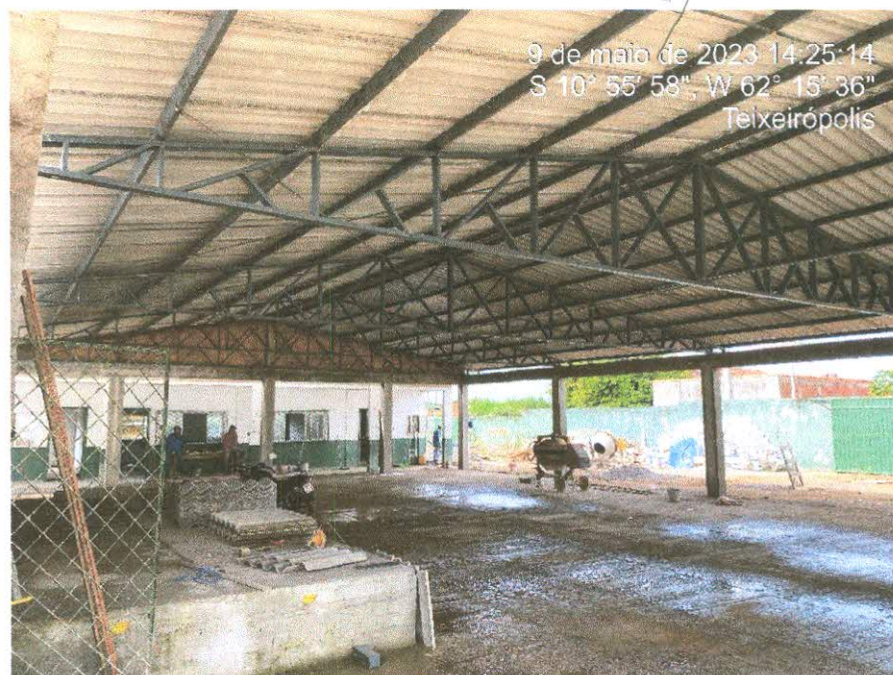
Figura 1: Estrutura metálica do pátio e telhamento com telha fibrocimento 6mm;
