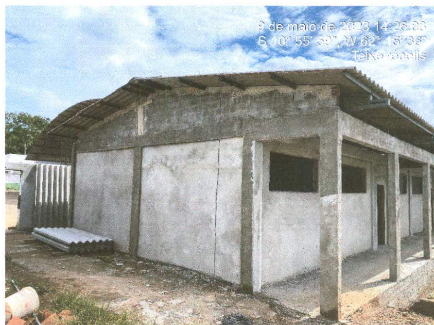
Figura 6: Telhamento com telha fibrocimento 6mm;
