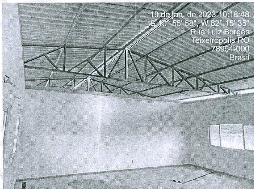
Figura 1: Percentual da estrutura metálica do telhado montada;
