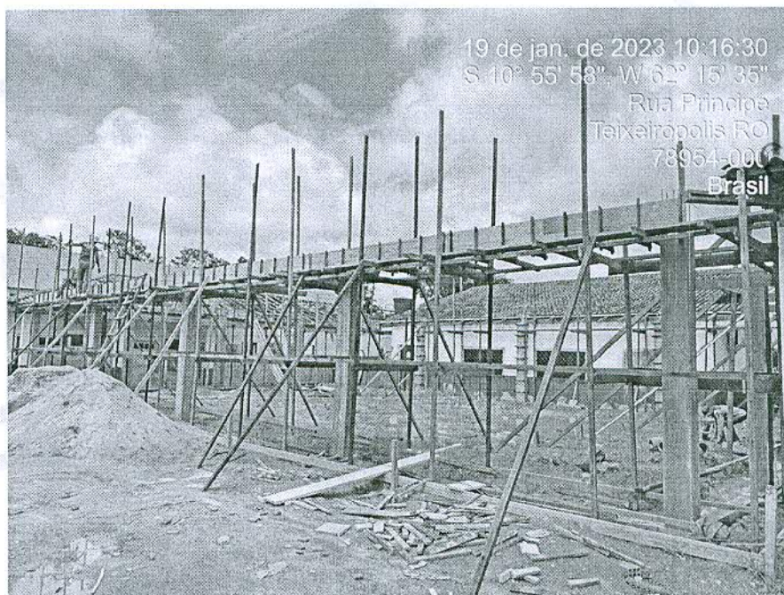
Figura 5: Pilares concretados e forma de viga respaldo sendo montada;
