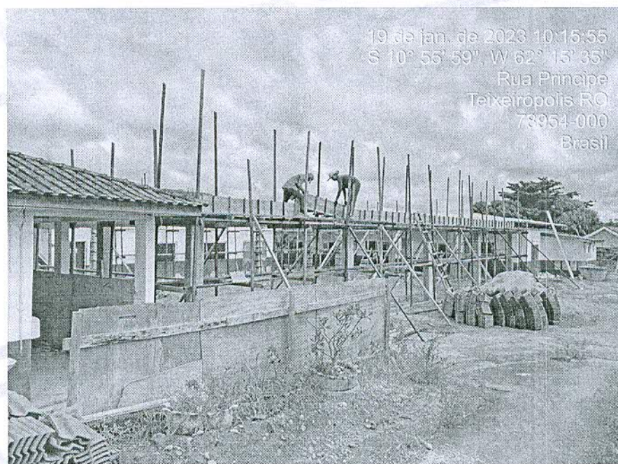
Figura 6: Pilares concretados e forma de viga respaldo sendo montada;
