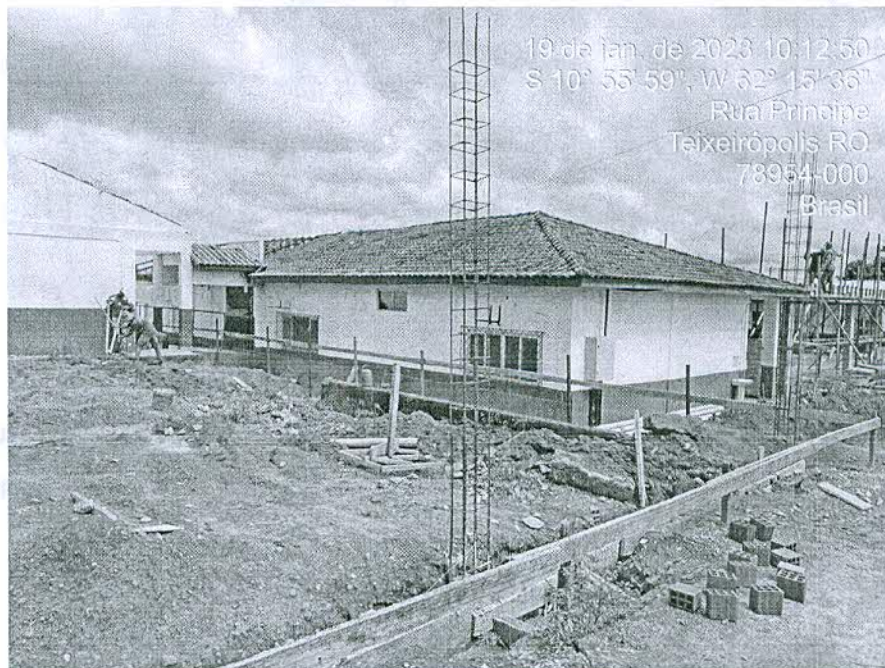
Figura 9: Fundação sendo executada na área da sala de aula;
