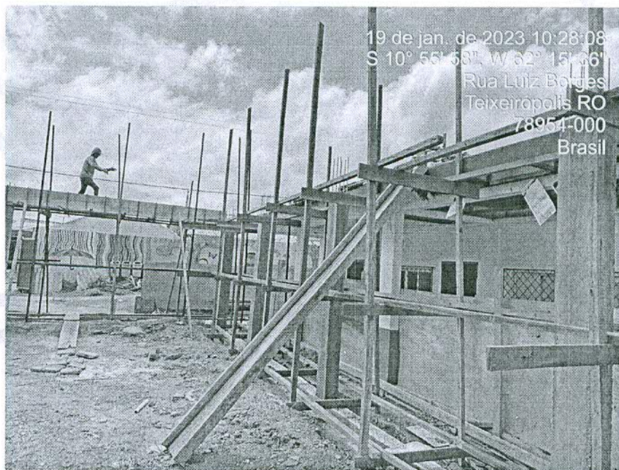
Figura 7: Pilares concretados e forma de viga respaldo sendo montada;
