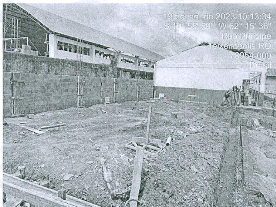
Figura 10: Fundação sendo executada na área da sala de aula;
