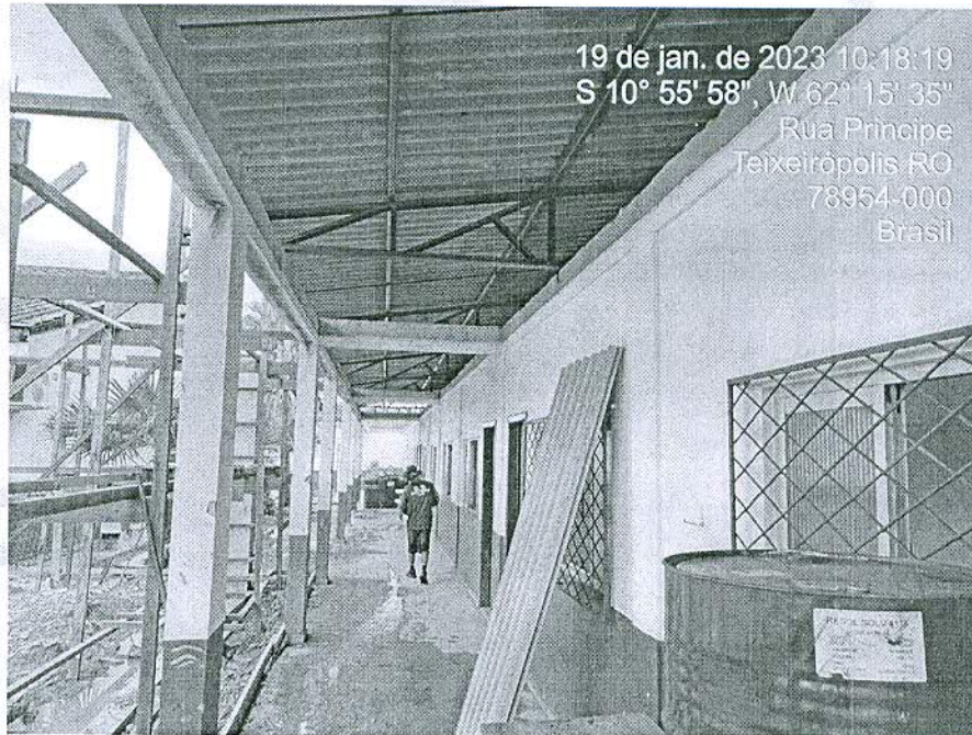
Figura 3: Telhamento com telha fibrocimento;
