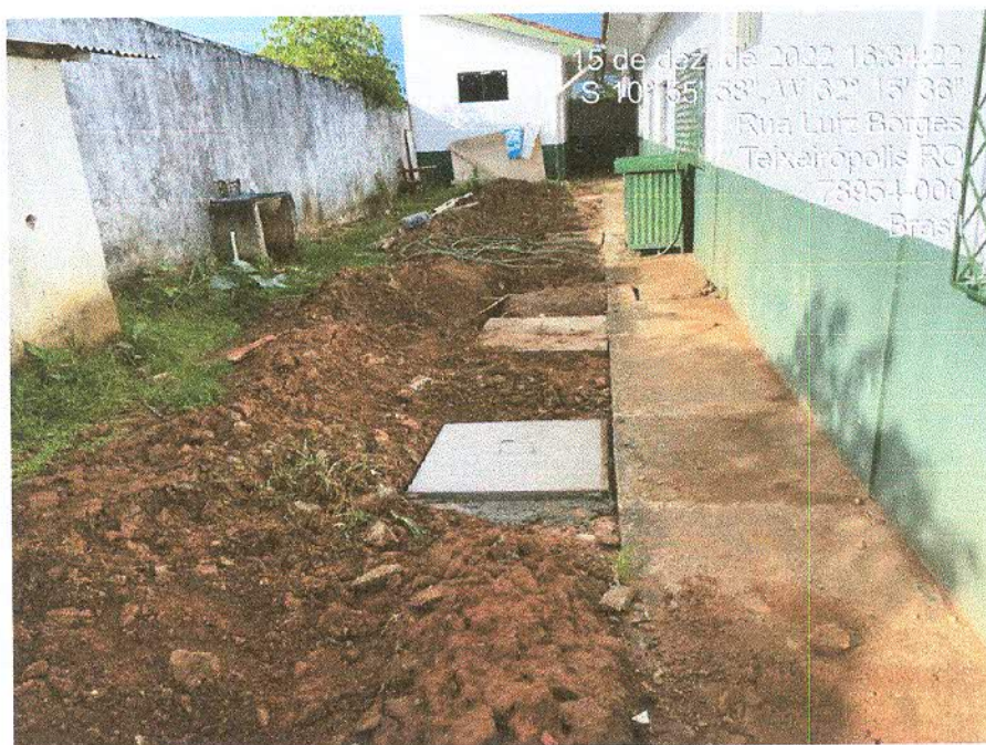
Figura 10: Caixas pluviais;
