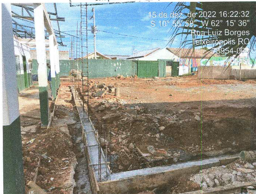
Figura 3: Infraestrutura do pátio concretada;
