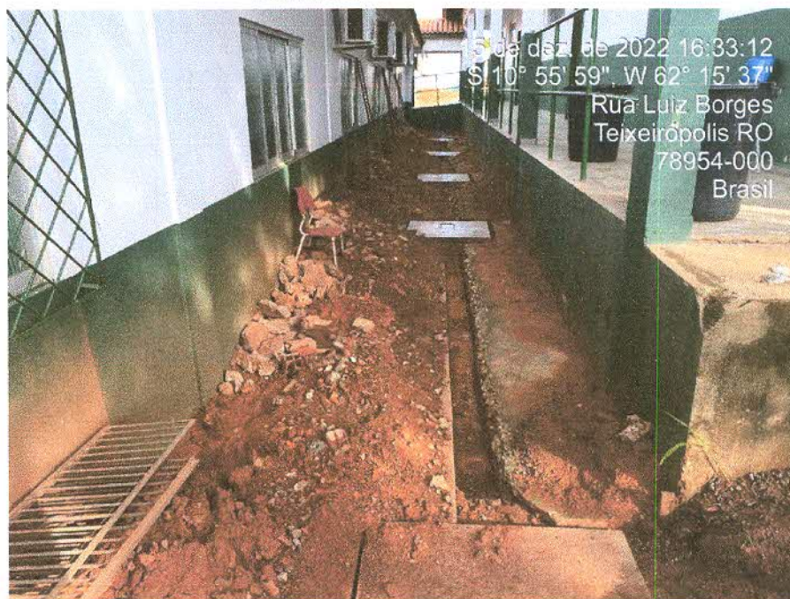
Figura 7: Caixas pluviais;
