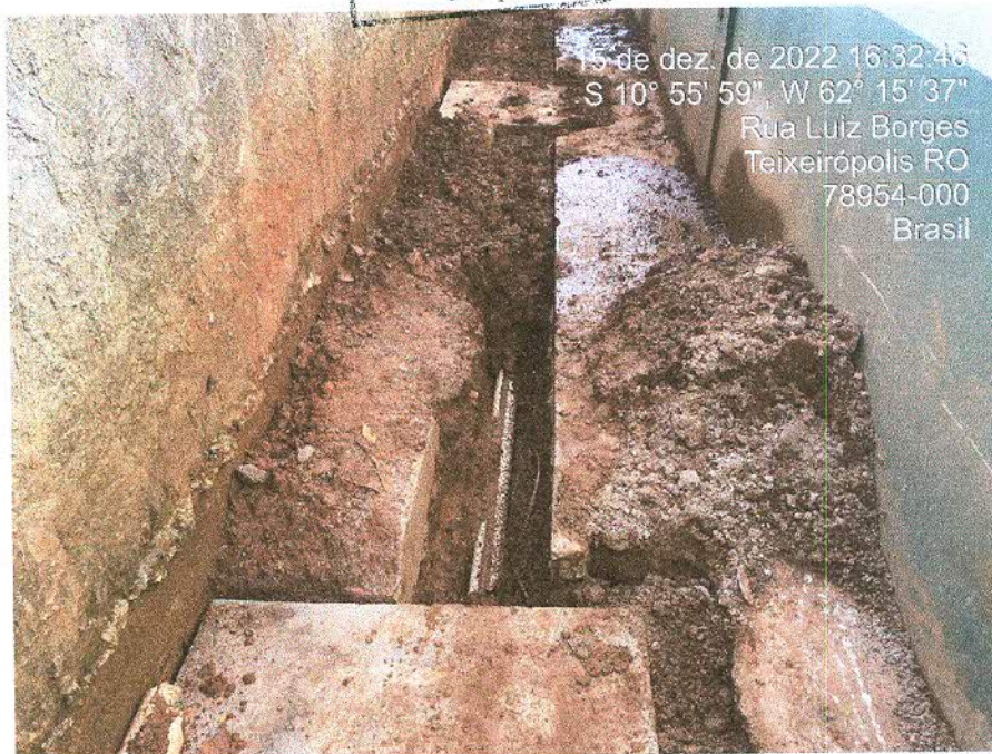
Figura 9: Caixas pluviais e tubulação 100mm;
