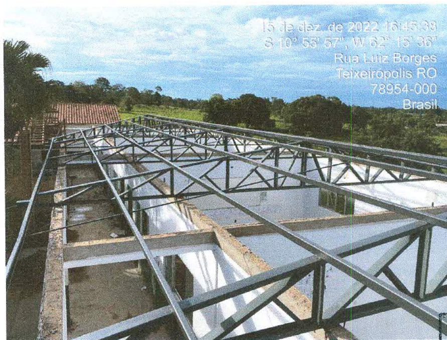
Figura 1: Percentual da estrutura metálica do telhado montada;
