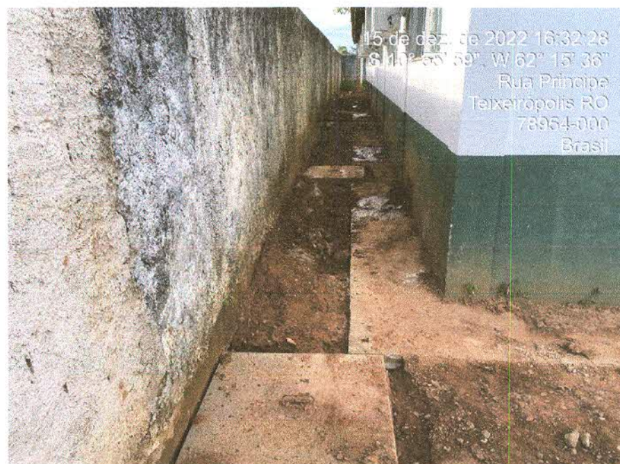
Figura 8: Caixas pluviais;
