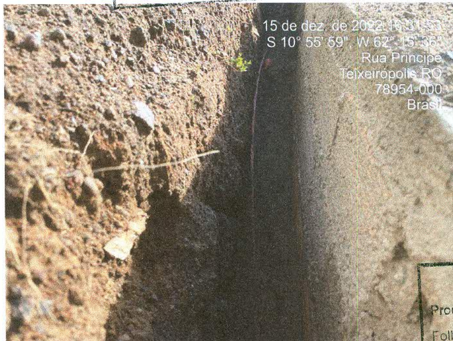
Figura 5: Cordoalha de cobre nu 50mm instalada;
