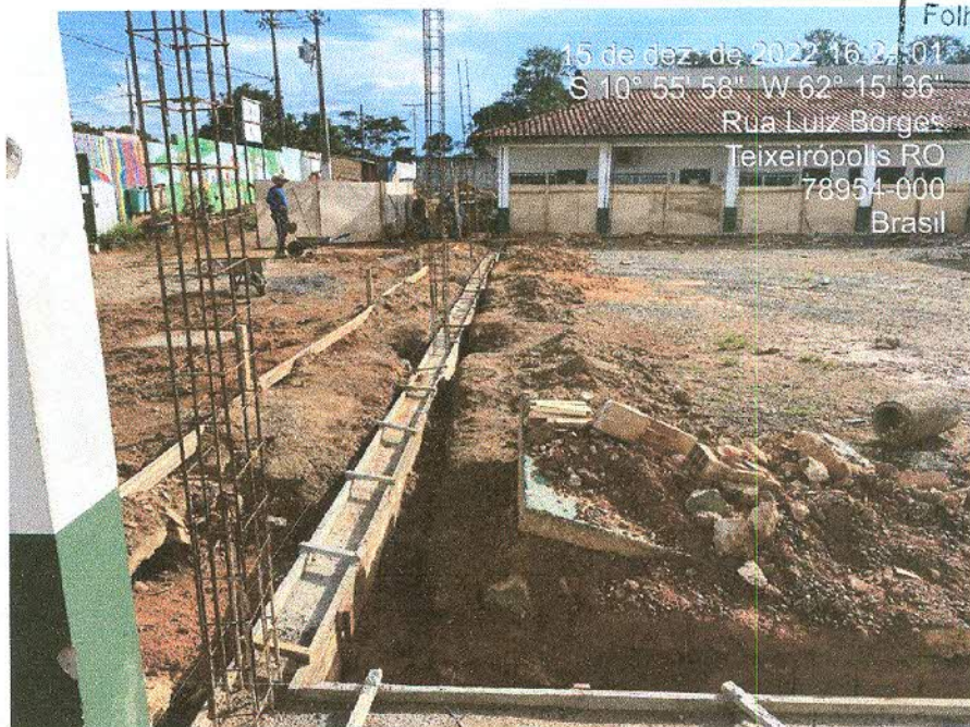
Figura 4: Infraestrutura do pátio concretada;
